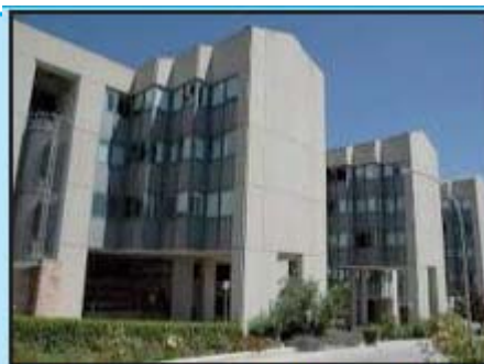
Il secondo edificio polifunzionale di via De Sanctis
