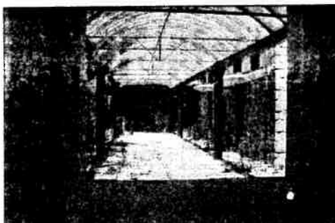
La vegetazione cresciuta all'interno della Casa dello Studente di Isernia
