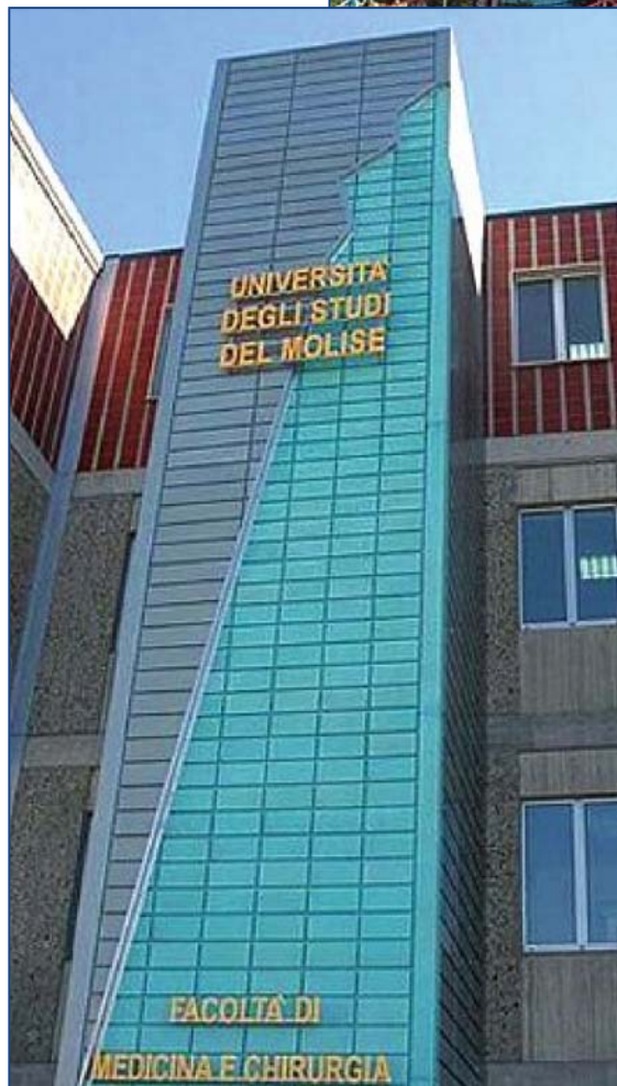
Nelle foto, il nuovo complesso della facoltà di Medicina del Molise
