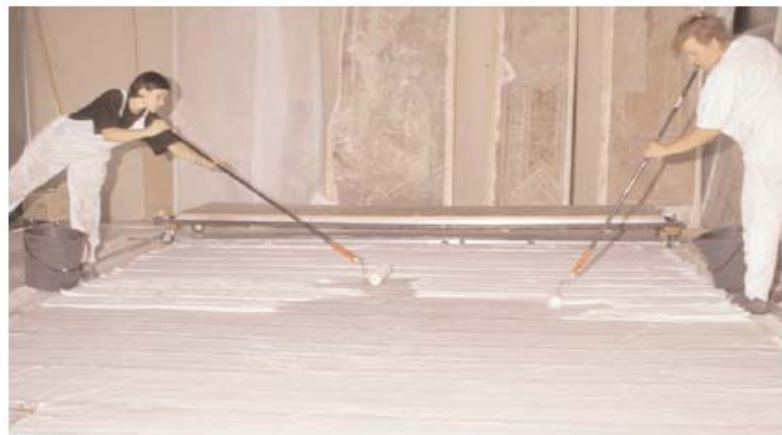
Fase del biorestauro dell'affresco di Spilvello Aretino "Conversione di S. Eliseo e battaglia" (xv secolo): applicazione del batteri sul telo di cotone precedentemente ricoperto di colla animale come strutturante prima dello "strappo" dalle superfici murali originarie del Camposanto Monumentale di Pisa
